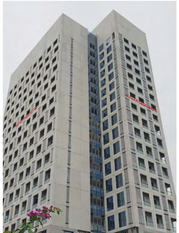
China setzt vor allem bei den Großprojekten in den Metropolregionen verstärkt auf Betonfertigteile, wie diese Baustelle zeigt.
